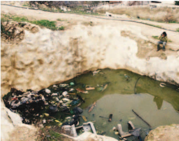
Eine Regenwasserzisterne, die aufgrund einer fehlenden Genehmigung von der israelischen Armee zerstört wurde – © Shabtai Gold /Irin
