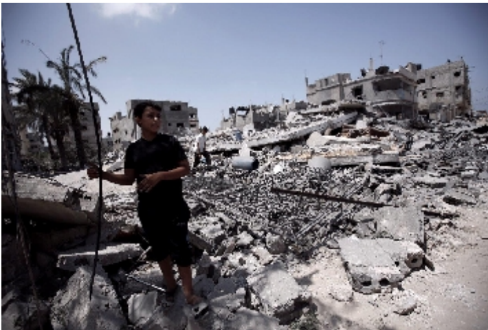
Ein Palästinenser inspiziert die Trümmer des zerstörten Wohnhauses der Familie al-Neirab nach den israelischen Luftschlägen im Süden von Gaza-Stadt, August 2014 © EPA/MOHAMMED SABER
